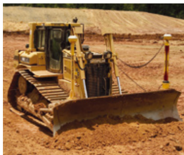
Travaux de terrassement
