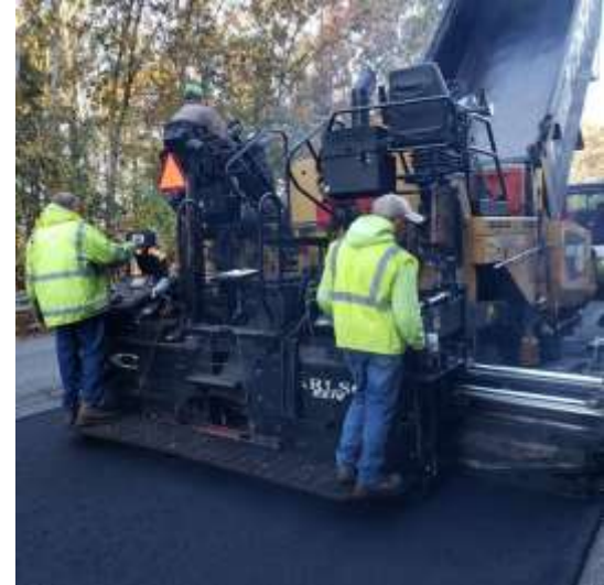
Display-ul Trimble Roadworks 2D este prevăzut cu tastaturi tactile pentru utilizare pe teren
